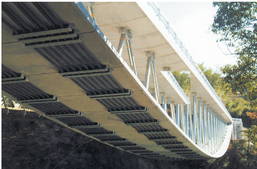
Rys.9. Most ukończony - widok dolnej „wstęgi” [7] Fig.9. Completed bridge – view of the bottom „ribbon” [7]
