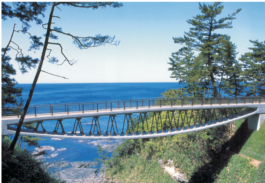
Rys.13. Kładka ukończona [6] Fig.13. Completed footway bridge [6]
