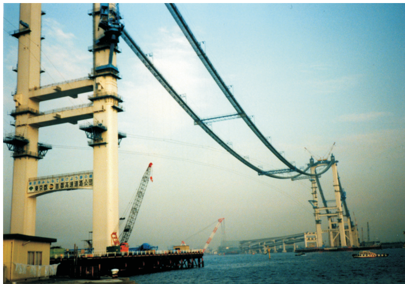
Rys.3. Pomosty robocze mostu wiszącego Fig.3. Mounting gangways of a suspension bridge (photo E.M. Kido: Rainbow Bridge 1991)
