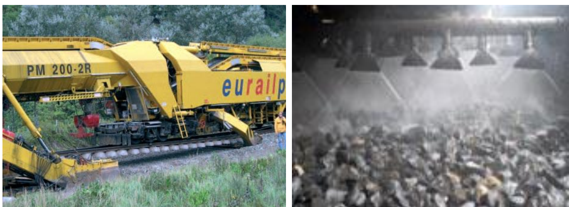
Rys. 9. Widok maszyny PM 200-2R do wymiany nawierzchni (z lewej). Widok płuczki ciśnieniowej czyszczącej podsypkę (z prawej) [2]
