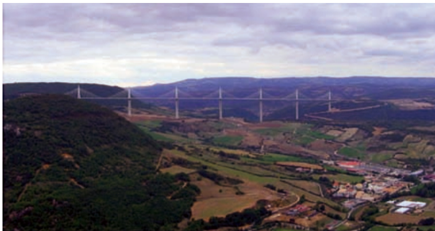
Fot. 4. Grand Viadue de Millau, architektura Norman Foster, konstrukcja Michel Virlogeux
