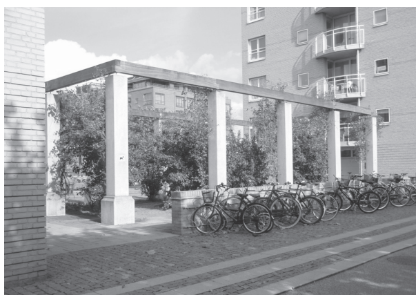
Ryc. 15. Parking rowerowy zabudowy mieszkaniowej w Kopenhadze (zdjęcie autora)
