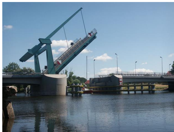
Rys. 6. Most w Drewnicy na Szkarprawie (skośne usytuowanie mostu w stosunku do osi rzeki).
