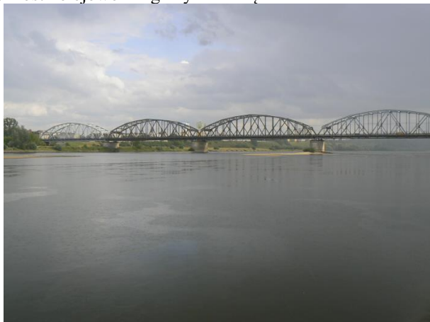
c) most kolejowo-drogowy Grudziądz
