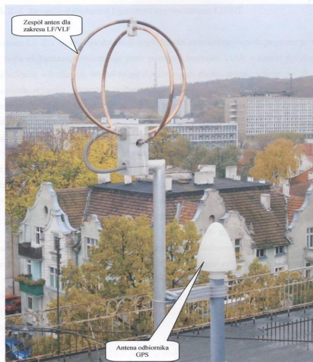
Rys. 4. Widok anteny systemu LINET zainstalowanej na budynku KWNiAE PG
