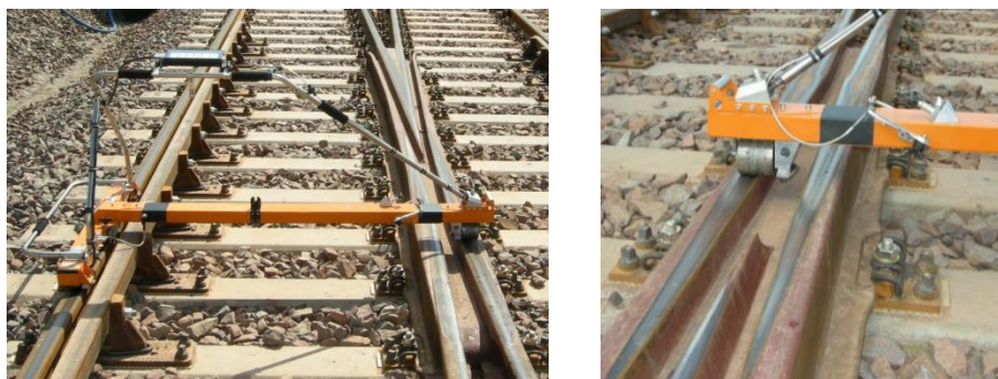
Fot. 4. Przejazd przez krzyżownicę – nieciągłość toku szynowego
