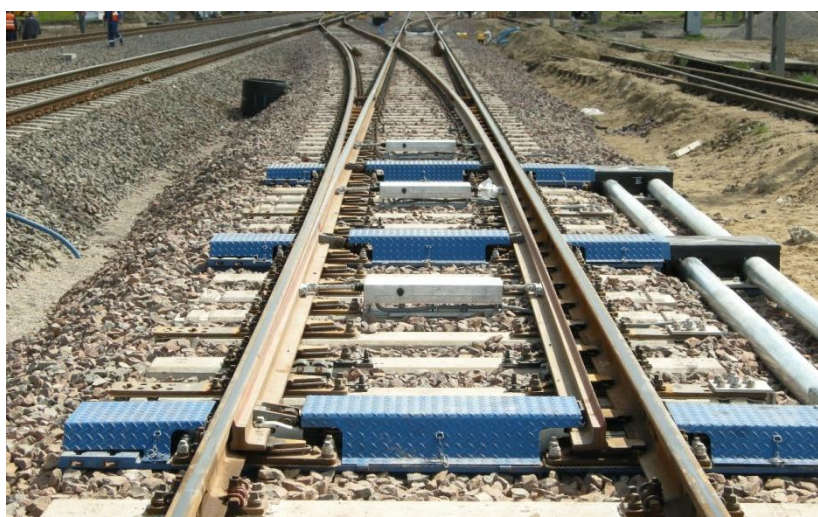
Fot. 2. Rozjazd zwyczajny lewy o promieniu 760 m
