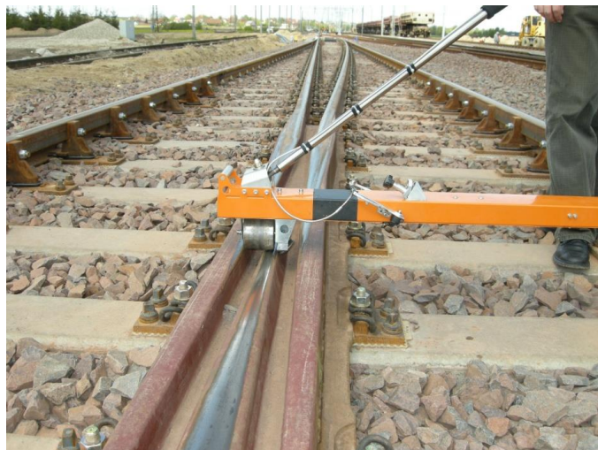
Fot. 5. Przejazd przez dziób krzyżownicy
