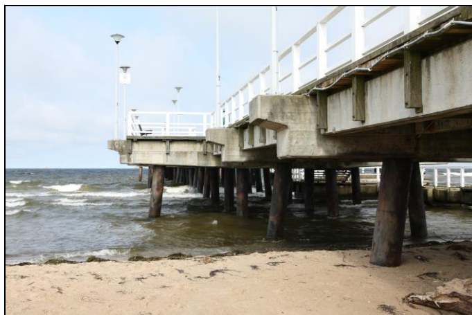
Rys. 2. Pale stalowe wykorzystane do budowy molo w Gdańsku Brzeźnie
