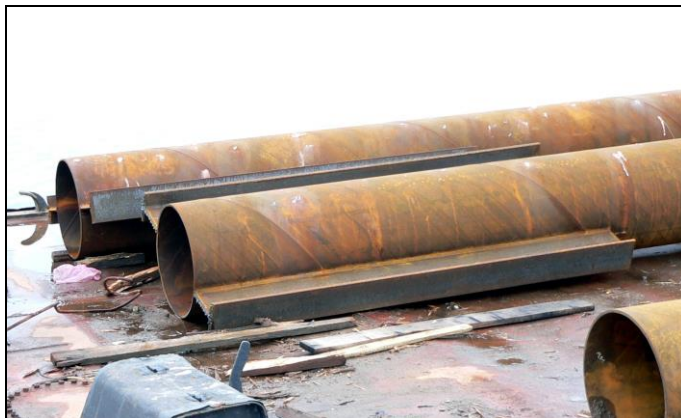
Rys. 5. Pali rurowe z dospawanymi „skrzydełkami”
