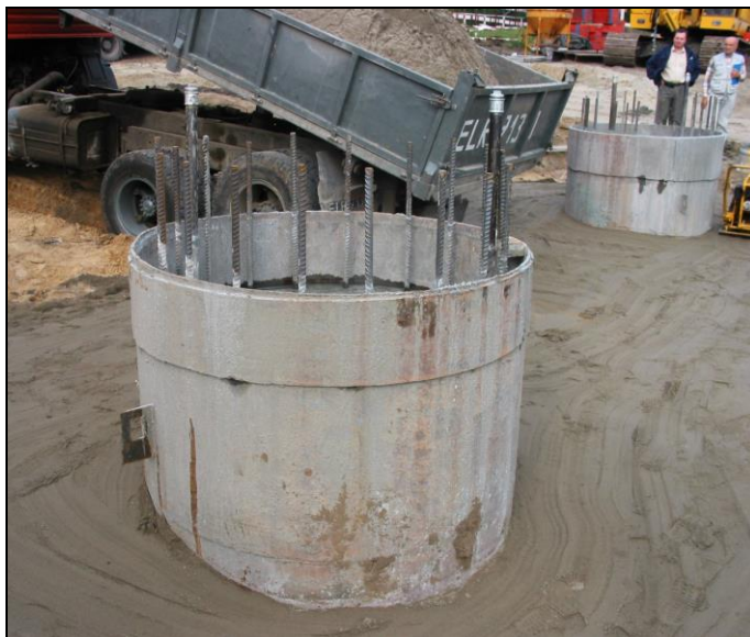
Rys. 14. Dwupalowe podpory mostu nad Nogatem
