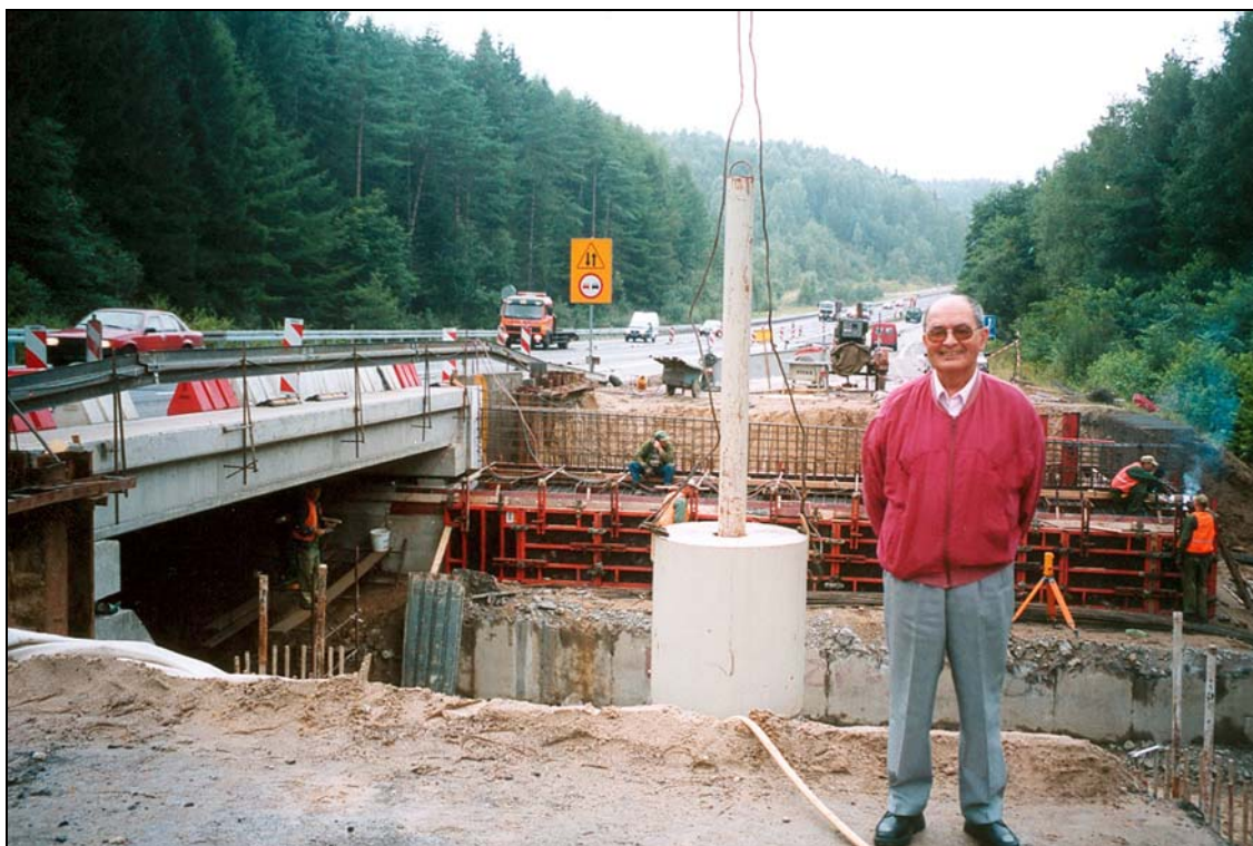
Rys. 2. Prof. A. Tejchman na tle stanowiska do badania dynamicznego nośności pła wierconego \phi 1200 mm, Obwodnica Trójmiasta, wiadukt 4B
