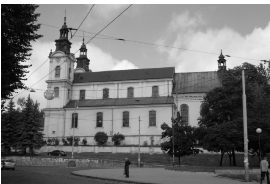
Rys.6. Aktualny stan kościoła oraz terenu, elewacja boczna (fot. R.Kinasz, 2006 r.) Fig.6. Current state of the church and the church site, side elevation
