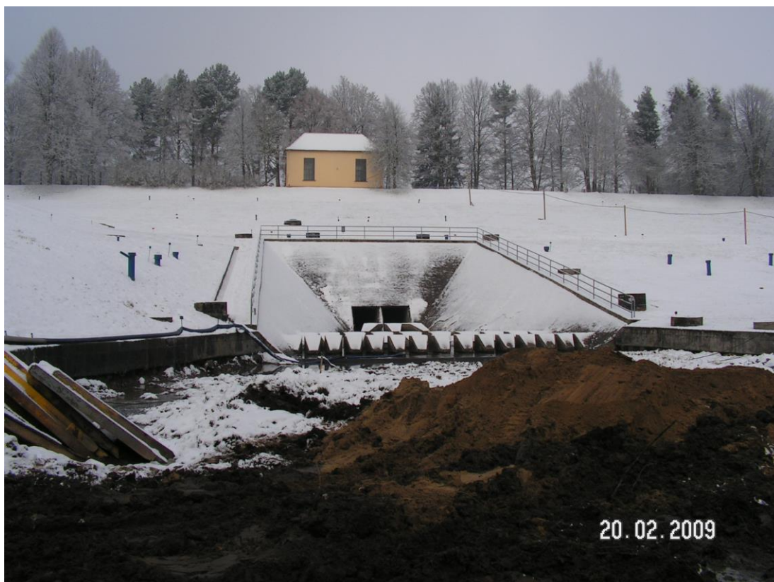
Rys. 2. Ogólny widok zapory Żur w okresie wykonywania robot
