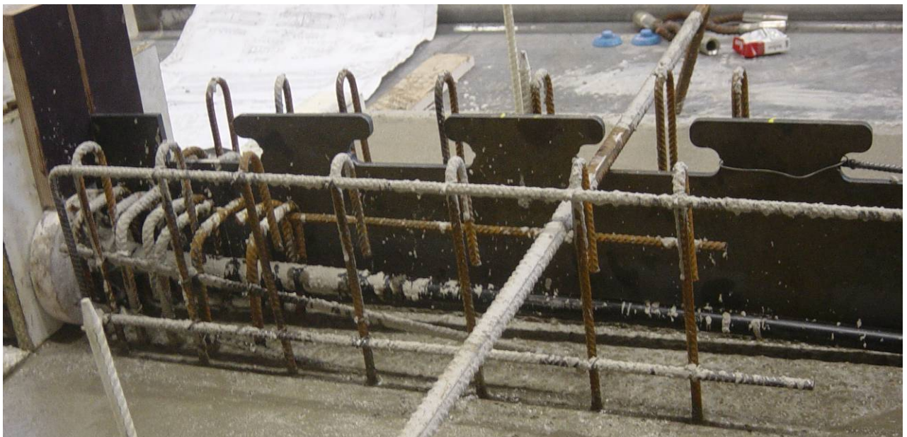
Bild 4: Geometrie einer Puzzleleiste
