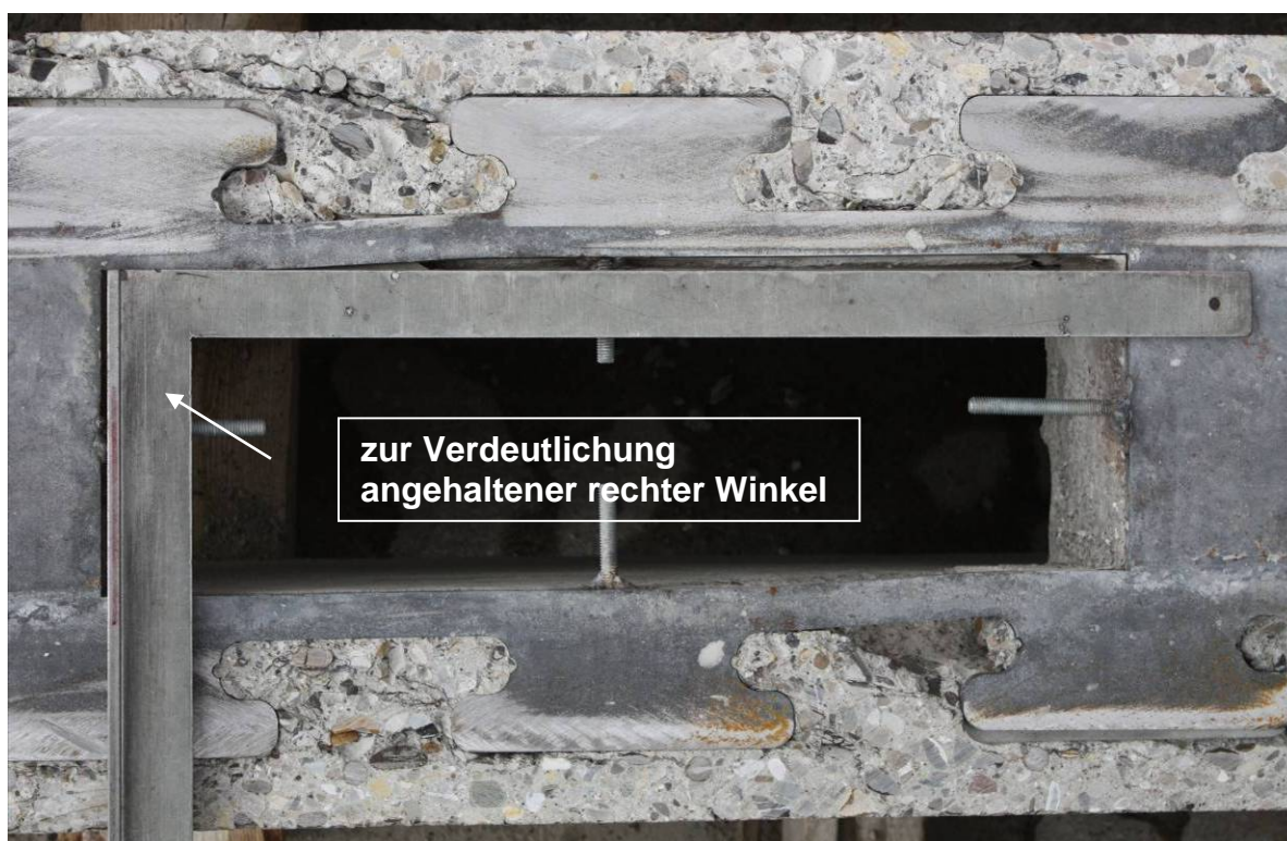
Bild 21: Eckige Stegöffnung nach Zersägen des Versuchsträgers
