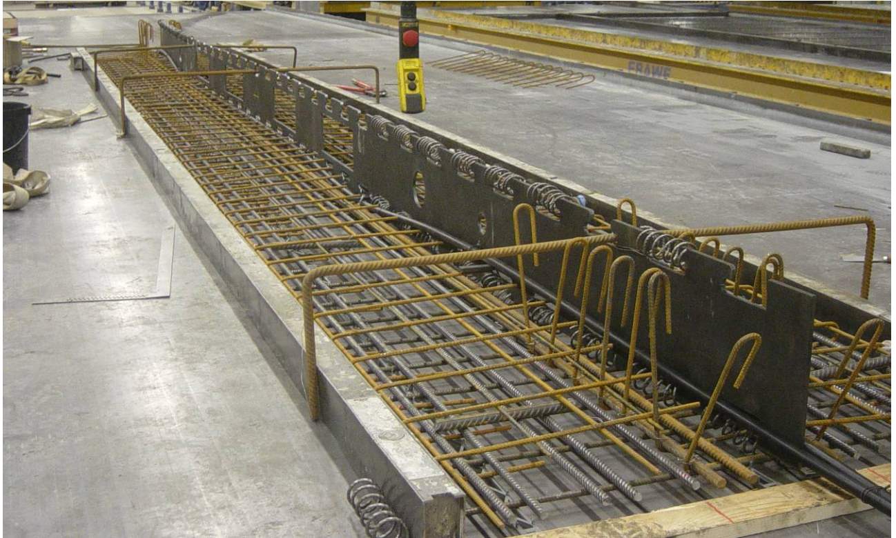
Bild 9: Eingebautes Stegblech mit Wendelbewehrung, Öffnungen und Spannkabel
