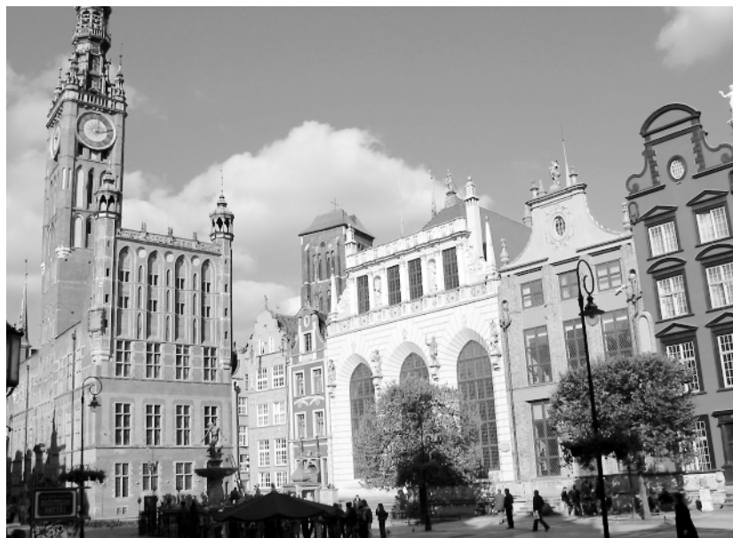
Ryc. 10. Część Długiego Targu w Gdańsku, z prawej strony Dworu Artusa widoczna nowa elewacja Nowego Domu Ławy. Stan w wrześniu 2003 r. (fot. K. Darecka)
