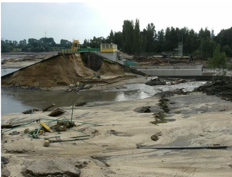
Rys. 1. Zniszczona zaporę ziemna Niedów na rz. Witka podczas powodzi w sierpniu 2010 r. ( http://www.zinfo.pl/galeria/187 )
