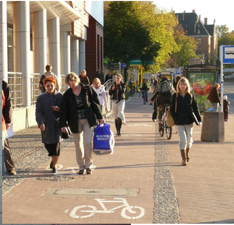
Fot.10. Ścieżka rowerowa przy al.Grunwaldzkiej oddzielona od ciągu pieszego brukową kostką.
