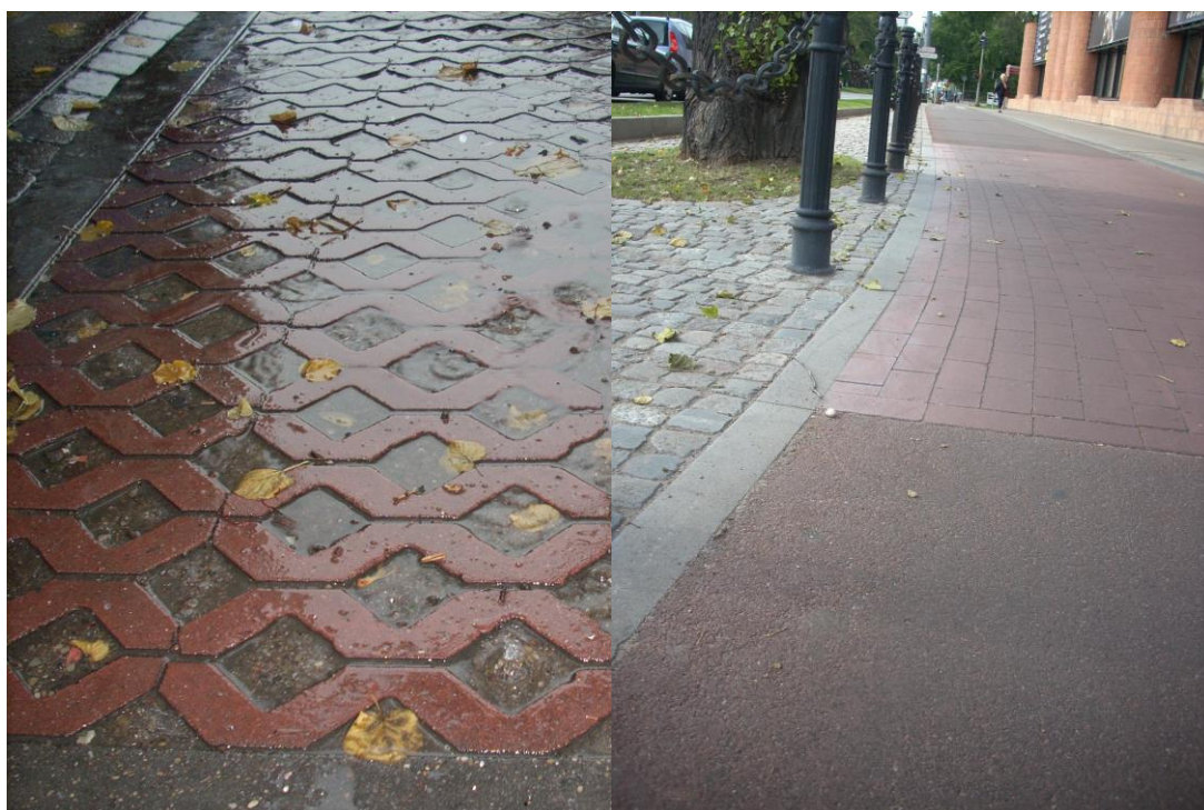
Fot.5. Przepuszczalna nawierzchnia z ażurowej kostki betonowej.
