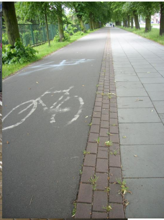
Fot.12. Niewielka różnica poziomów dodatkowo rozdzielająca ścieżkę rowerową od ciągu pieszego.
