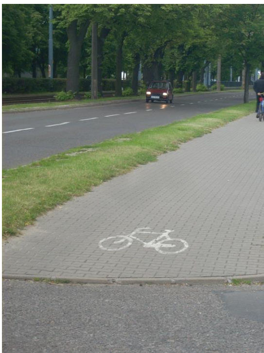
Fot.7. Ścieżka rowerowa pomiędzy jezdniami wzdłuż ul. Pomorskiej.
