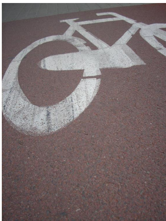
Fot.1. Bitumiczna nawierzchnia ścieżki rowerowej.
