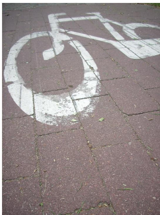
Fot.2. Nawierzchnia ścieżki rowerowej z gładkiej kostki brukowej.
