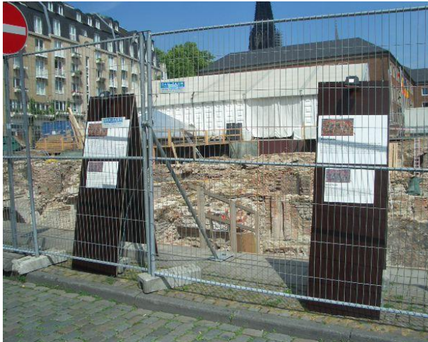
Fot 7. Ogrodzenie terenu prac rekonstrukcyjnych dzielnicy żydowskiej w centrum Kolonii.
