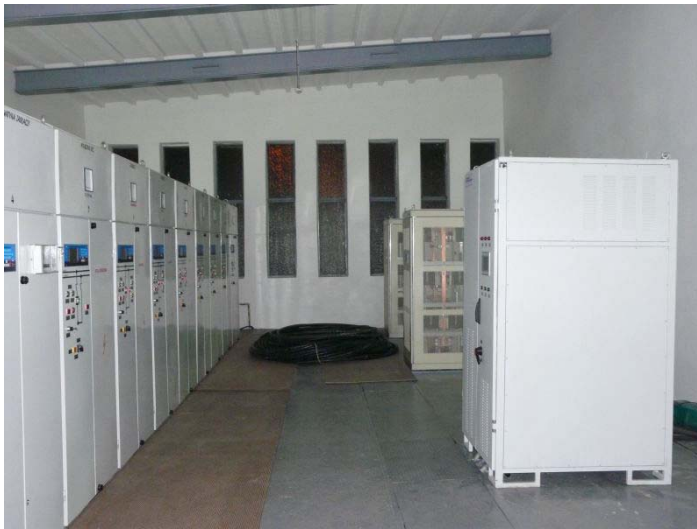
Rys. 1. Zasobnik superkondensatorowy zainstalowany w trolejbusowej podstacji trakcyjnej Północna w Gdyni.
