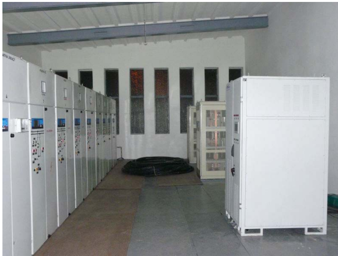
Rys. 1. Zasobnik superkondensatorowy zainstalowany w trolejbusowej podstacji trakcyjnej Północna w Gdyni.
