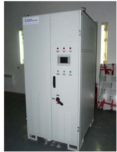
Rys. 1. Zasobnik superkondensatorowy zainstalowany w trolejbusowej podstacji trakcyjnej Północna w Gdyni.
