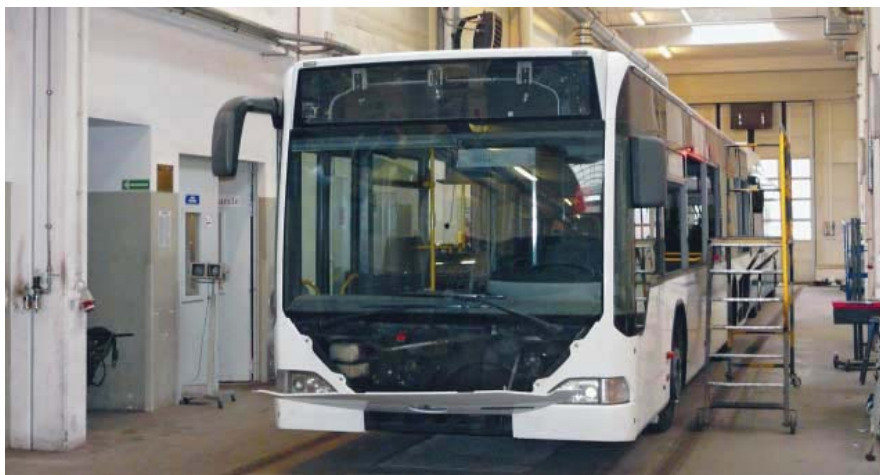
Fot. 09.jpg: Nadwozie autobusu Mercedes Benz O530 w trakcie prac dostosowawczych w procesie konwersji na trolejbus, Gdynia, zajezdnia trolejbusowa na Grabówku, 24.03.2011 r.
