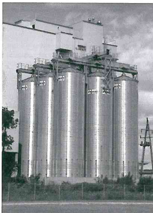
Rys. 1. Bateria silosów cylindrycznych
