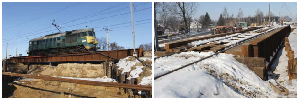
Rys.1. Widok ogólny konstrukcji odciążającej KO85
