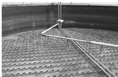
Rys. 6. Rozmieszczenie dyfuzorów na dnie reaktora SBR
