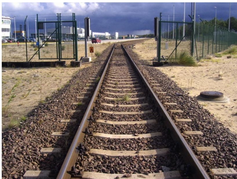
Fot.3. Wjazd na bocznicę terminala DCT
