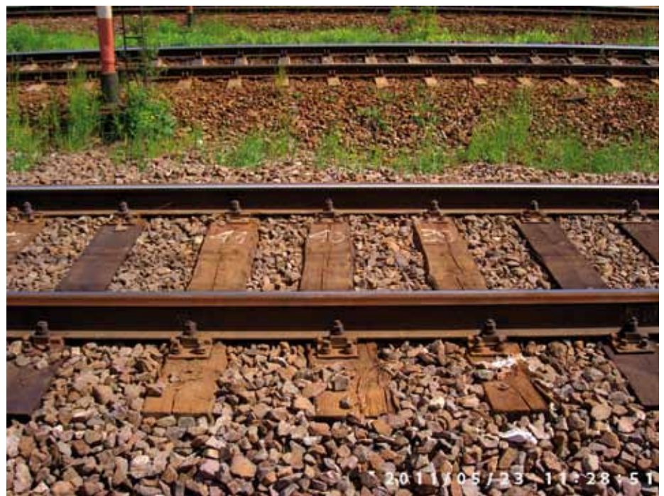
3. Przykład fotografii fragmentarycznej – widoczne numery podkładów
