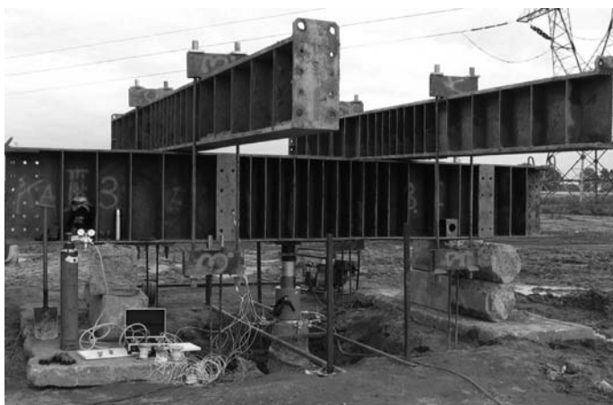
Rys. 6. Stanowisko do badań statycznych nośności pali na polniku doświadczalnym
