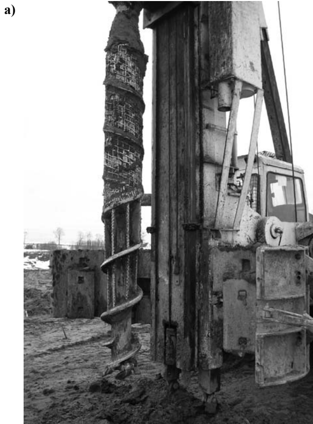
Rys. 19. Świdry przemieszczeniowe: a) CMC \phi 400 mm – poletko „Małdyty 1”, b) SDP \phi 400 mm – poletko „Małdyty 2”
