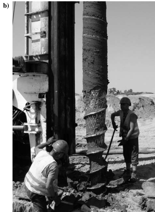
Rys. 19. Świdry przemieszczeniowe: a) CMC \phi 400 mm – poletko „Małdyty 1”, b) SDP \phi 400 mm – poletko „Małdyty 2”
