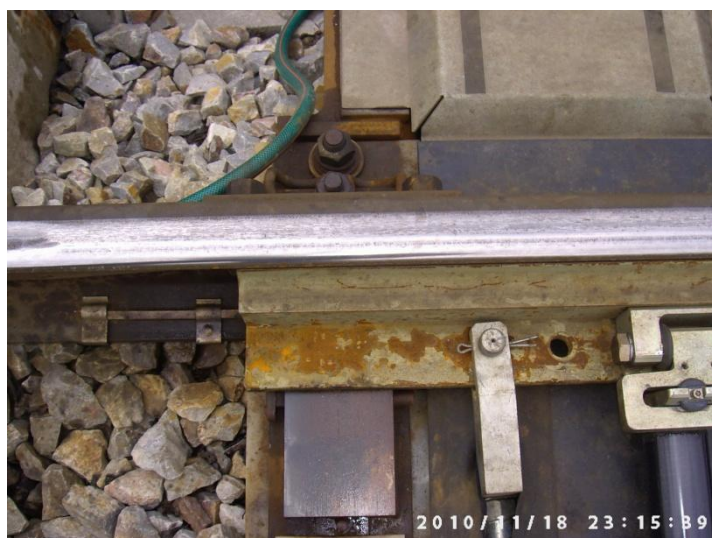
Fot.1. Widok opornicy prostej i iglicy łukowej (przyleganie iglicy do opornicy)
