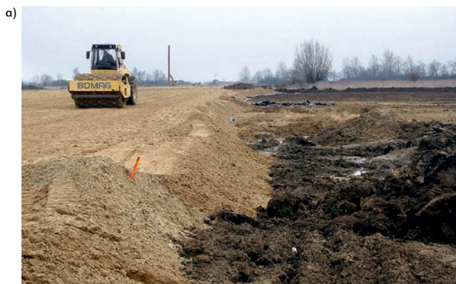
Fot. 2. Dogęszczanie platformy roboczej
