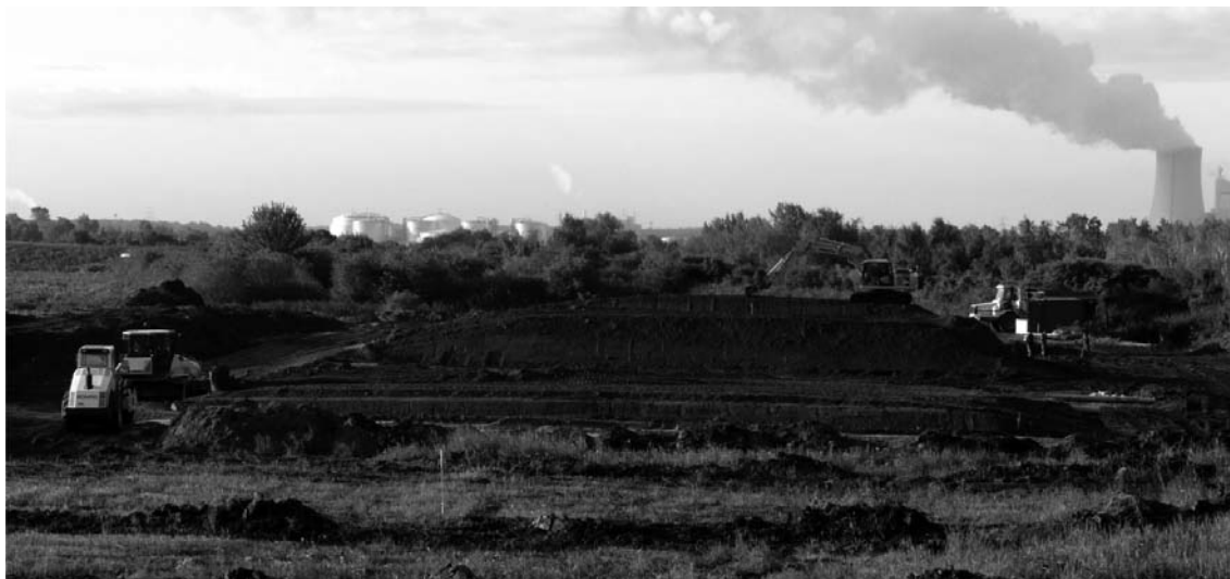
Rys. 7. Budowa wałów poprzecznych w sierpniu 2011 r.
