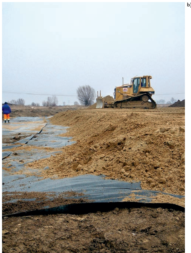
Fot. 1. Proces wykonywania platformy roboczej: ułożenie geotkaniny i rozścielenie warstwy piasku
