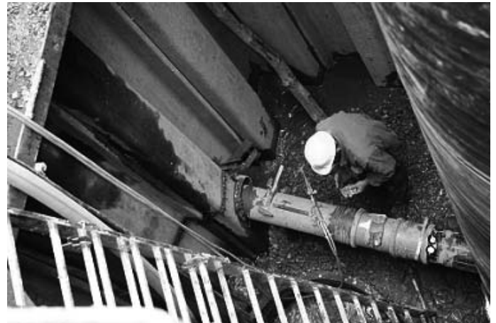
Rys. 6. Montaż lekkiej studzienki (TEGRA, WAVIN) w tradycyjnej technologii w warunkach rozmytego podłoża
