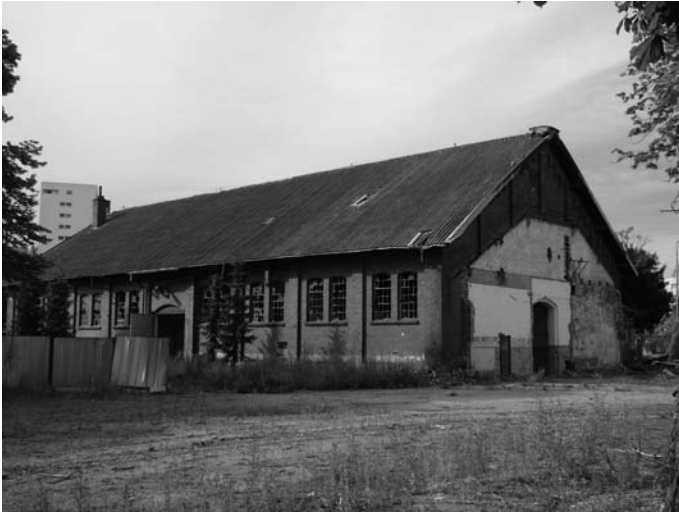
Rys. 1. Budynek Wozowni – stan istniejący
