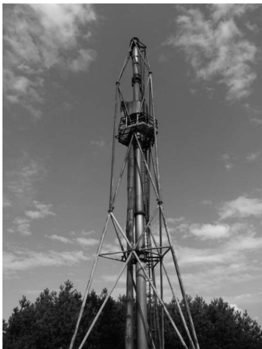
Rys. 8. Widok ogólny obiektu
