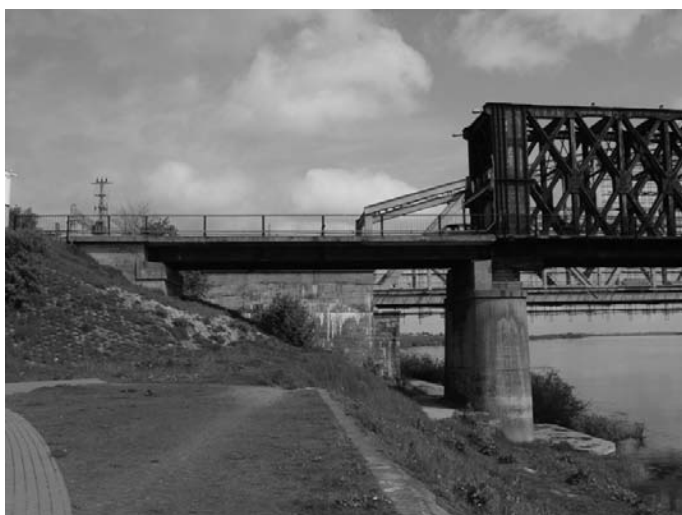
Rys. 4. Fotografia przedstawia stan obecny wjazdu na most, gdzie pierwotnie znajdowały się bramy portalowe (fotografia własna)
