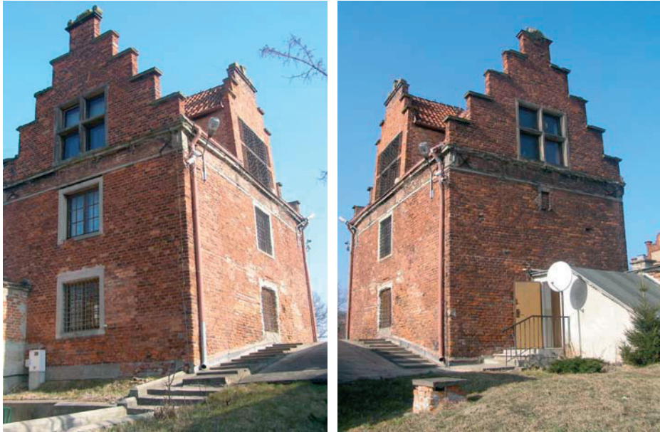
Rys. 4. Wartownia z widocznymi rurami spustowymi oraz fragment korony wału nad przejazdem
