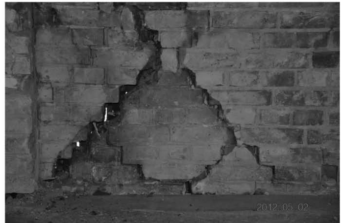
Rys. 2. Uszkodzenia murów (widok od strony wnętrza budynku oraz widok od strony elewacji zewnętrznych)
