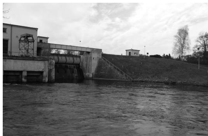
Rys. 6. Ogólny widok stopnia wodnego Smukała i remontowanej przylądki drenażowej
