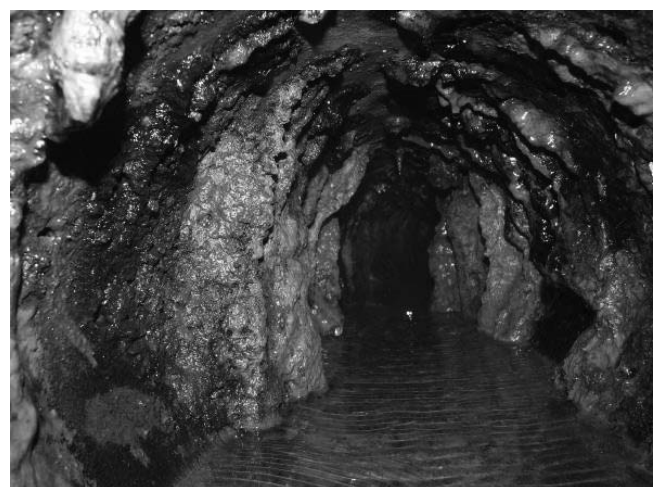
Rys. 14. Ogólny stan zniszczonego drenażu po prawej stronie budynku elektrowni
