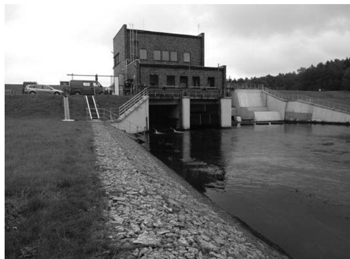
Rys. 13. Umocnienie brzegu na dolnym stanowisku EW Ptusza na rzece Gwdzie
