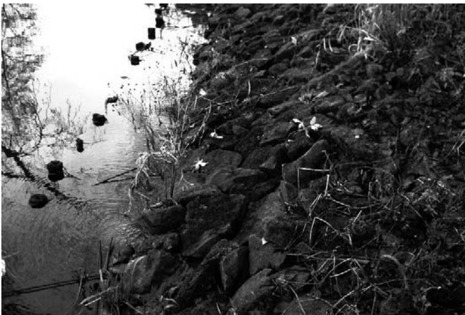
Rys. 10. Umocnienie brzegu narzutem kamiennym. Schemat istniejącej konstrukcji
