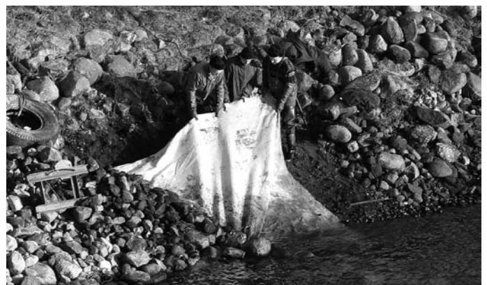
Rys. 9. Układanie geowłókniny na skarpie
