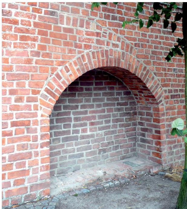
Il. 5. Przekształcona w XVI w. średniowieczna wnęka w parterze ściany wschodniej dawnego browaru. Stan z 2011 r. (fot. A. Piwek)
