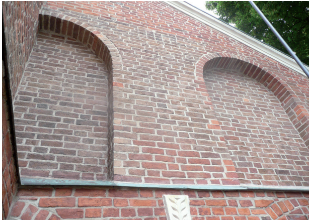
Il. 3. Wnęki znajdujące się w części górnej ściany wschodniej dawnego budynku gospodarczego. Należą one do jedynych średniowiecznych detali, jakie się zachowały. Stan z 2010 r. (fot. A. Piwek)
