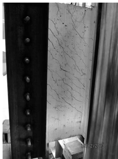
Rys. 12. Szczegół zarysowania wspornika tarczy DB-II
