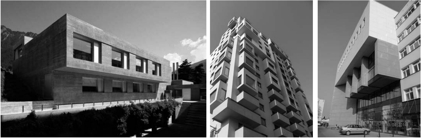
Rys. 1. Przykłady zastosowania tarcz wspornikowych
