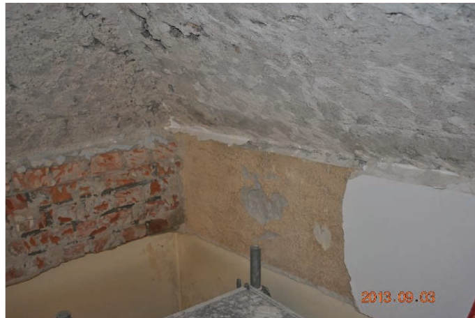
Rys. 8. Naroże N1 od strony północno-wschodniej [6]
