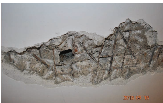
Rys. 7. Zbrojenie powłoki w odkrywce od strony wewnętrznej łupiny [6]
