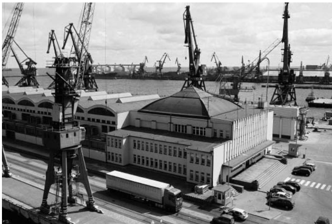
Rys. 2. Widok Dworca Morskiego w Gdyni od strony północnej (Nabrzeża Francuskiego), (2011 r.). (Źródło fot.: http://stefanbatoryoceanliner.weebly.com/gdynia-port.html )
