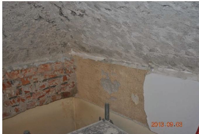
Rys. 8. Naroże N1 od strony północno-wschodniej [6]
