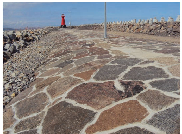
Rys. 17. Widok na wyremontowany dawny korpus
