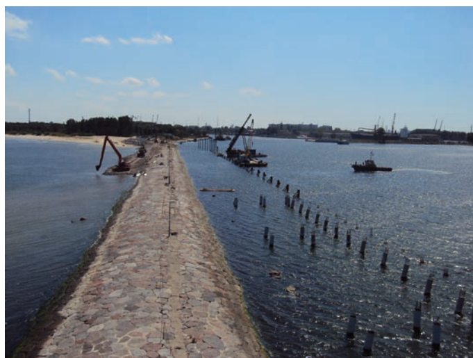
Rys. 10. Prace katarowe i nasypowe
