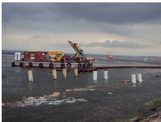
Rys. 11. Wykonywanie mikropali w części głowicowej
