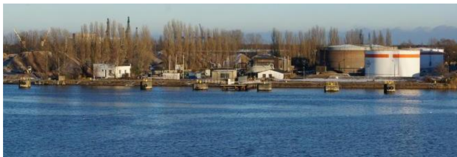
Rys. 2. Terminal przeładunkowy oraz baza magazynowa spółki COMAL – widok od Martwej Wisły
