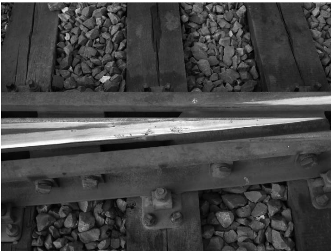
Rys. 13. Uszkodzenia na powierzchni dzioba krzyżownicy
