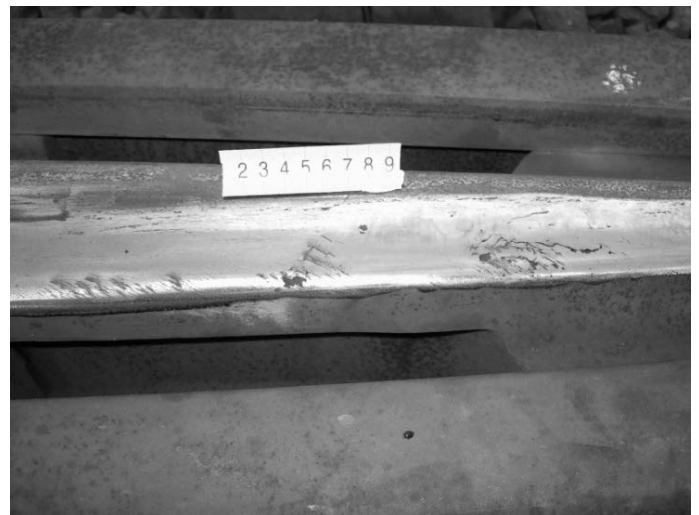
Rys. 13. Uszkodzenia na powierzchni dzioba krzyżownicy
