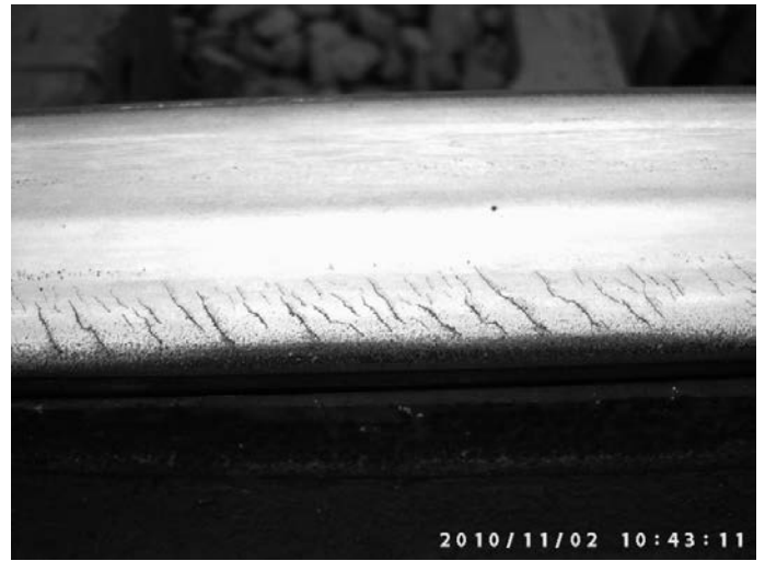
Rys. 12. Wady head check na powierzchni tocznej opornicy
