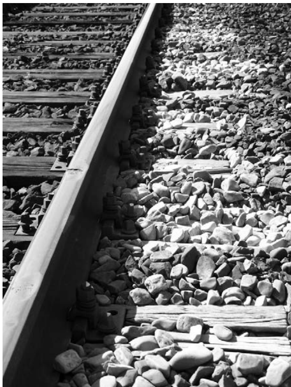
Rys. 9. Wada squat – wychłapki na długości kilku podkładów
