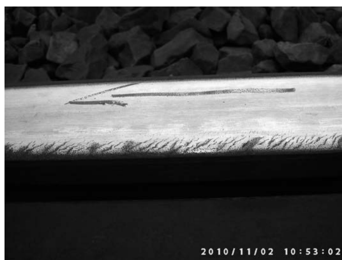
Rys. 16. Uszkodzenia head check na powierzchni toczonej szyny przy kierownicy
