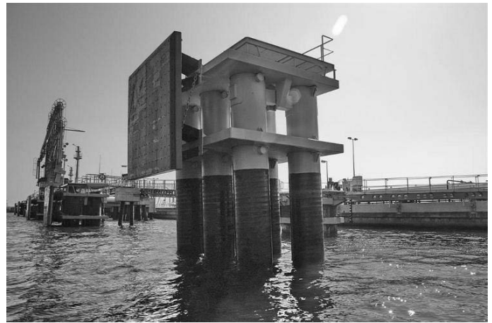
Rys. 2. Przykładowa dalba odbojowa, [6] (inna niż na rys. 1a)
