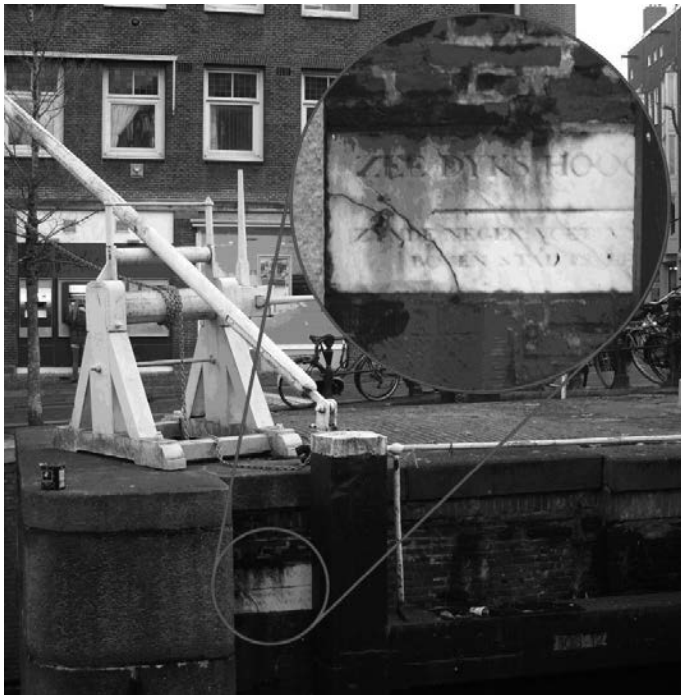
Rys. 5. Oryginalna (i w powiększeniu) tablica z wyźłobioną linią na ścianie słuzy Eenhoornsluis w Amsterdamie [21]
