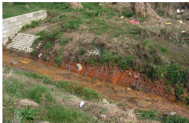
Rys. 10. Zabagnienie terenu przyległego do rowu i spływające do niego żelaziste wody gruntowe
