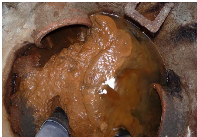
Rys. 11. Galaretowata postać żelaza wytrąconego z wody gruntowej w rurze drenarskiej (z lewej) i na dnie studni (z prawej)
