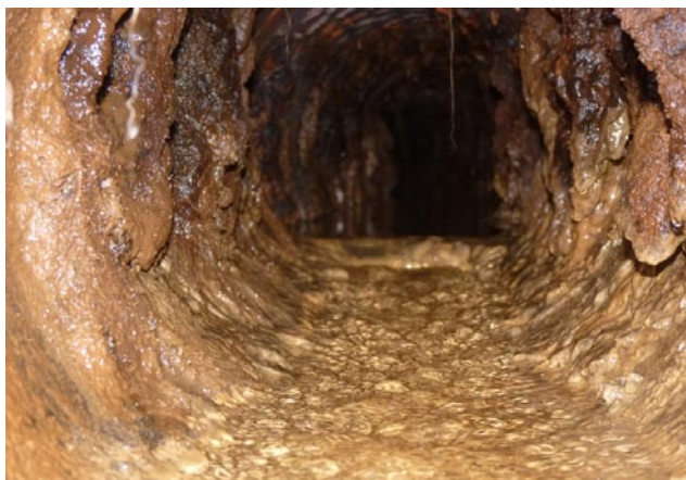
Rys. 11. Galaretowata postać żelaza wytrąconego z wody gruntowej w rurze drenarskiej (z lewej) i na dnie studni (z prawej)
