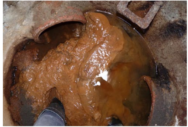
Rys. 11. Galaretowata postać żelaza wytrąconego z wody gruntowej w rurze drenarskiej (z lewej) i na dnie studni (z prawej)
