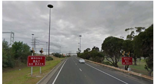
Rys. 4. Tablice połączone ze światłami ostrzegawczymi na autostradzie w USA
