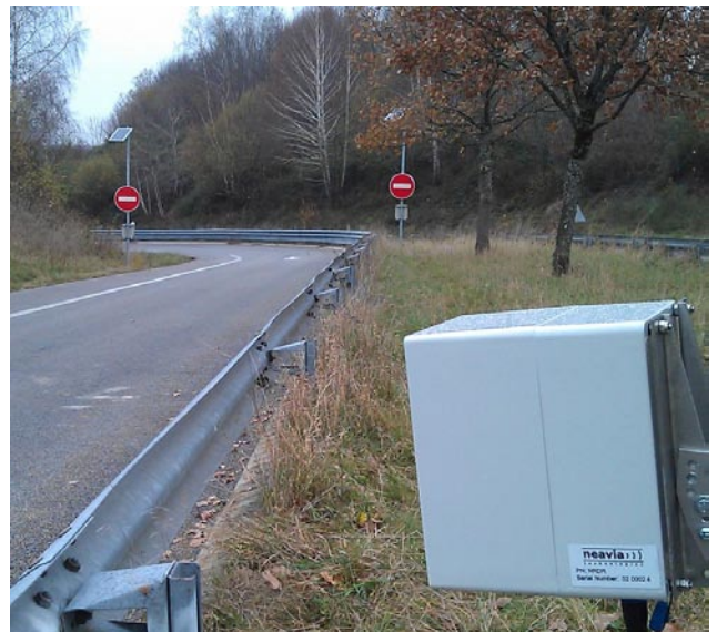
Rys. 5. Radarowy czujnik wyłapujący pojazdy jadące w niewłaściwą stronę
