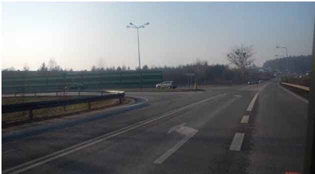
Rys. 2. Skrzyżowanie ul. Spacerowej i Obwodowej w Trójmieście. Jedyne niemal niewidoczny znak C-9 wskazuje prawidłowy pas wjazdu na obwodnicę. Gdy podwójna linia rozdzielająca pokryta jest śniegiem lub błotem, to strzałka oznakowania poziomego kieruje wprost na niewłaściwy pas ruchu
