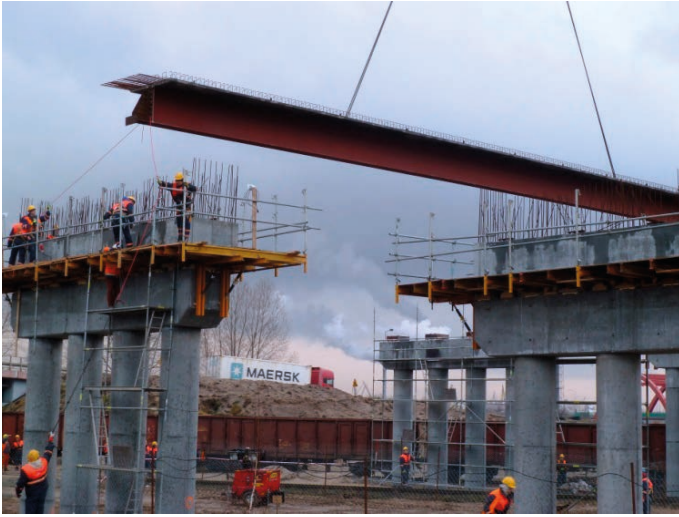
Rys. 1. Prace montażowe przy budowie wiaduktu WD-7 na Trasie Sucharskiego w Gdańsku
