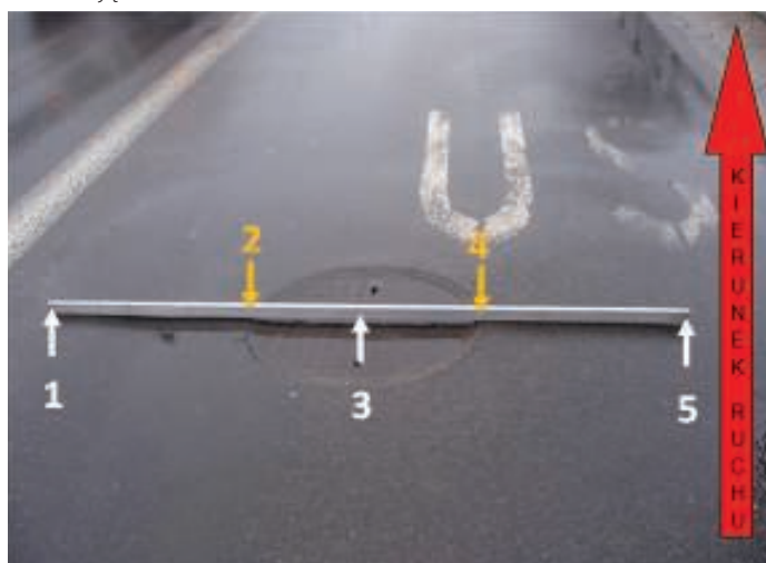
4. Sposób pomiaru deformacji studni – położenie A
