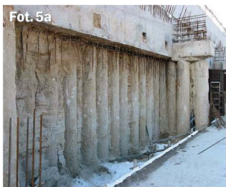
Palisada z pali CFA Średnica pali: 500 mm Długość pali: 9,5–12 m Głębokość wykopu: ok. 6,5 m Schemat statyczny: jednokrotnie zakotwiona
