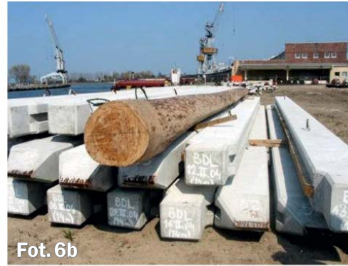
Fot. 6. Prefabrykaty żelbetowej ścianki szczelnej nabrzeża w Porcie Gdańskim (fot. K. Gwizdała)
