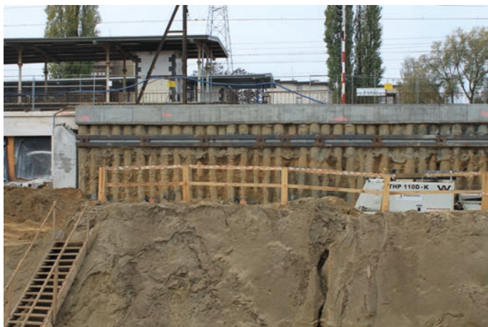
Rys. 6. Budowa Nowego Centrum Sopotu. Wykop – I faza
