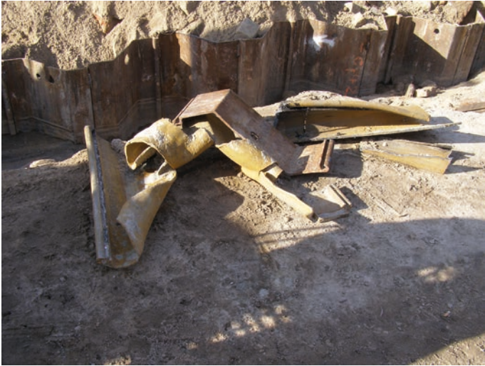
Rys. 1. Uszkodzone podstawy ścianki szczelnej wciskanej przy realizacji tunelu w Sopocie [24]
