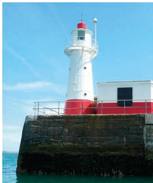
Rys. 7. Stacja mareograficzna obok latarni morskiej w Newlyn [31]
