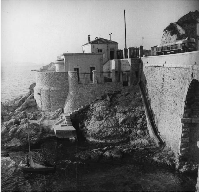
Rys. 12. Budynek stacji mareograficznej w Marsylii [36]
